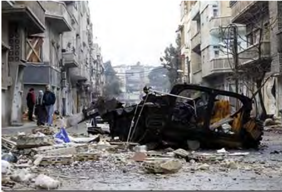
Daños a escuelas en Damasco por la guerra de Siria 7/enero/2014
