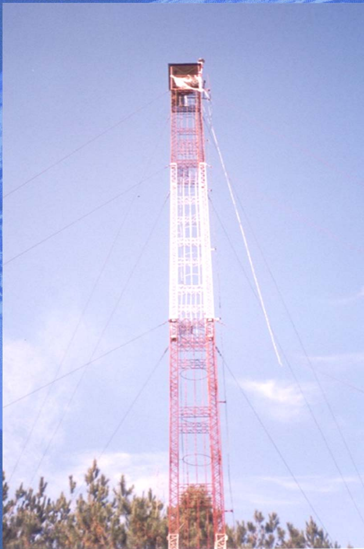
TORRE CONTROL DE INCENDIOS
