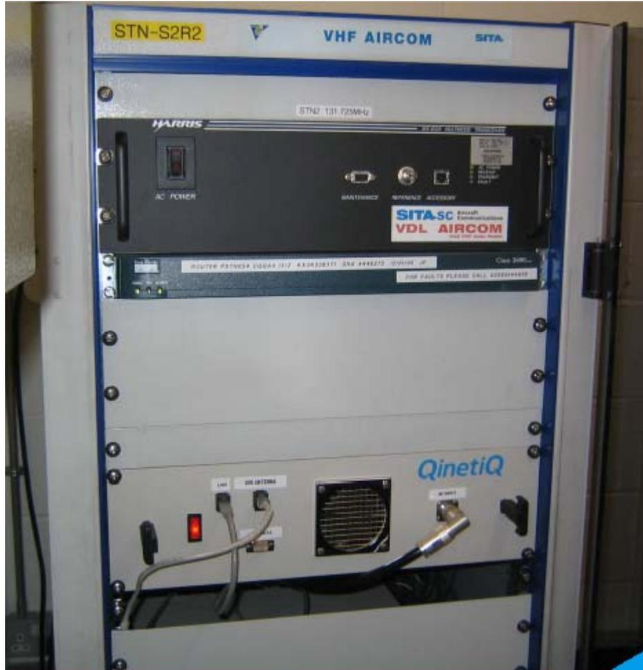
*Fig 1 - Station VHF SITA avec récepteur ADS-B*
